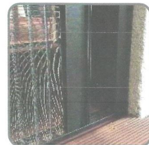
Profil bezklamkowy, próg 8 mm
